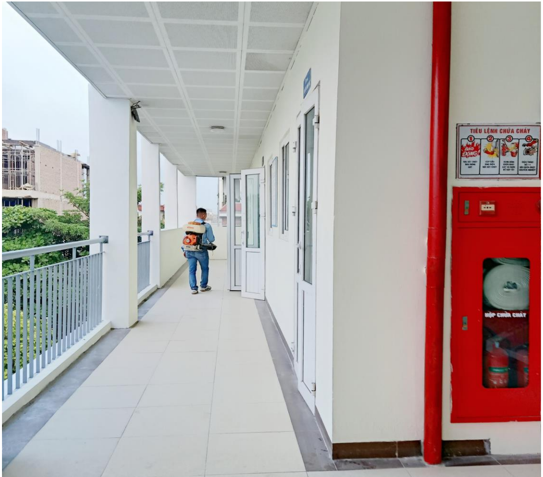
Phun toàn bộ khu vực hành lang các khu A, B, C
