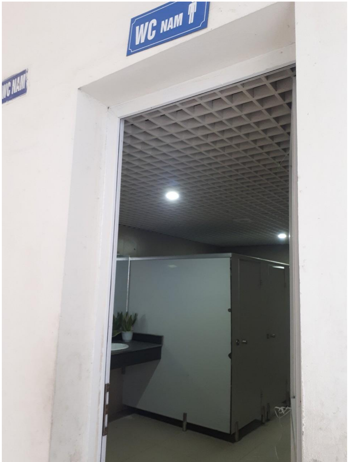
Xây dựng nhà vệ sinh sạch sẽ, thân thiện
