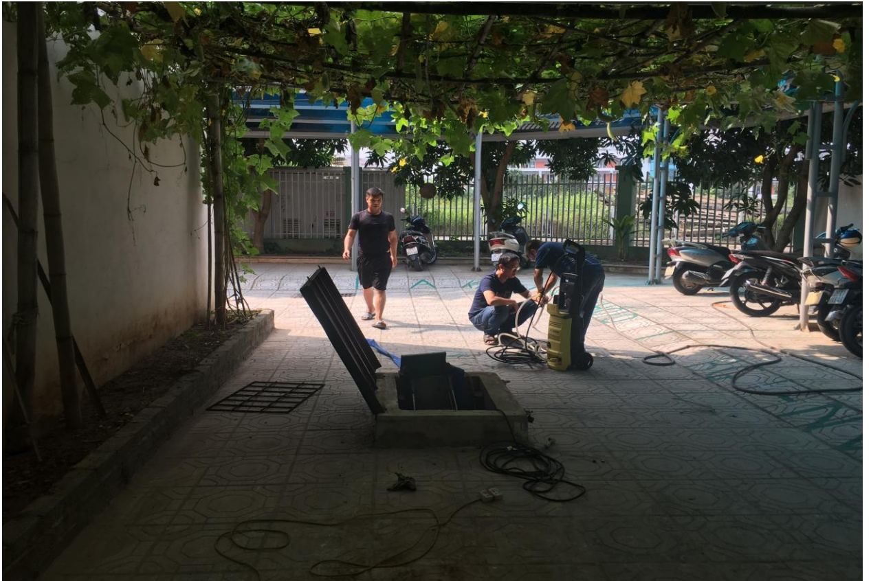
Hình ảnh nhân viên công ty nước sạch thau dọn bể chứa nước sạch
