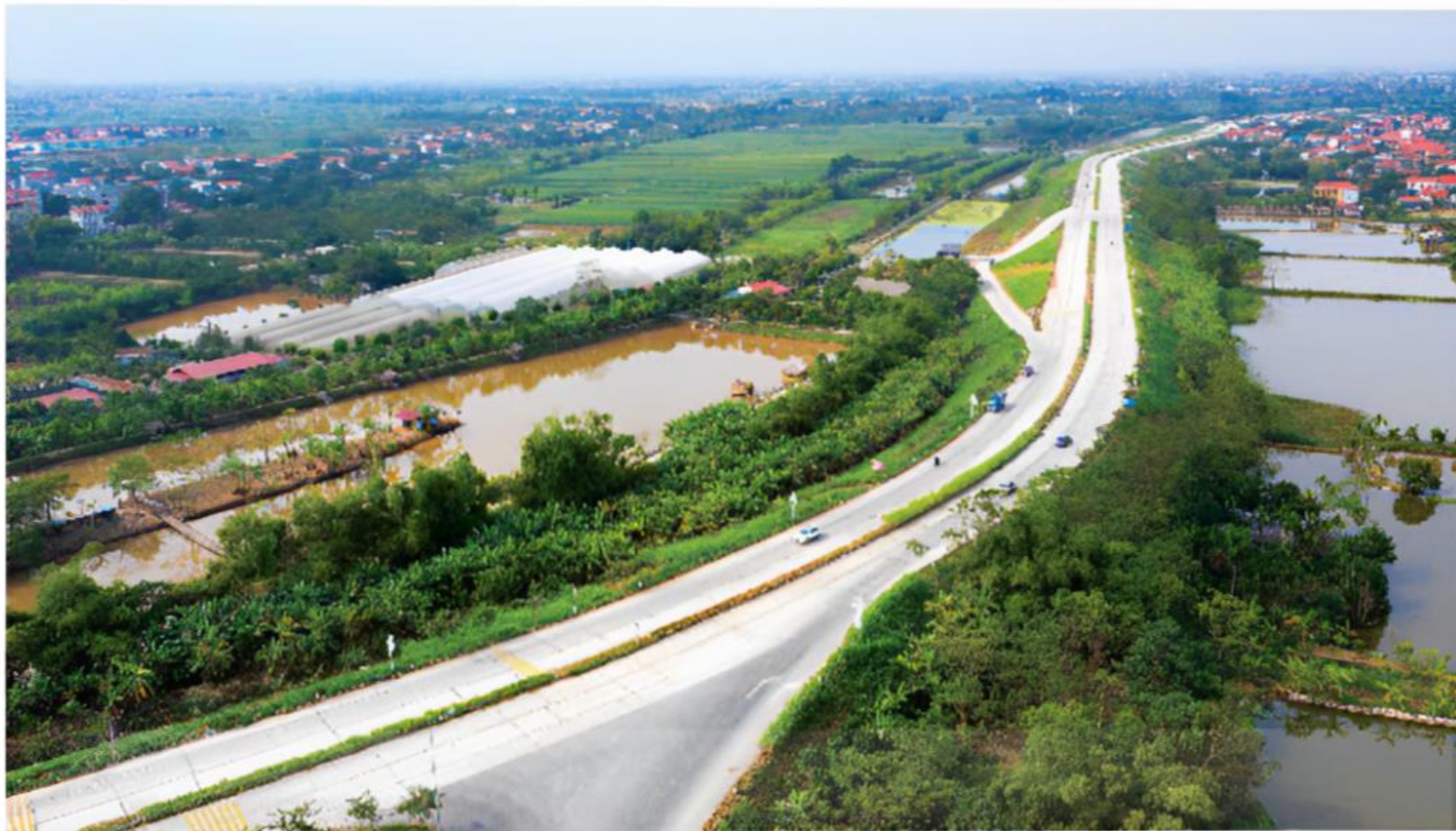
▲ Hình 5. Một đoạn đê sông Hồng
