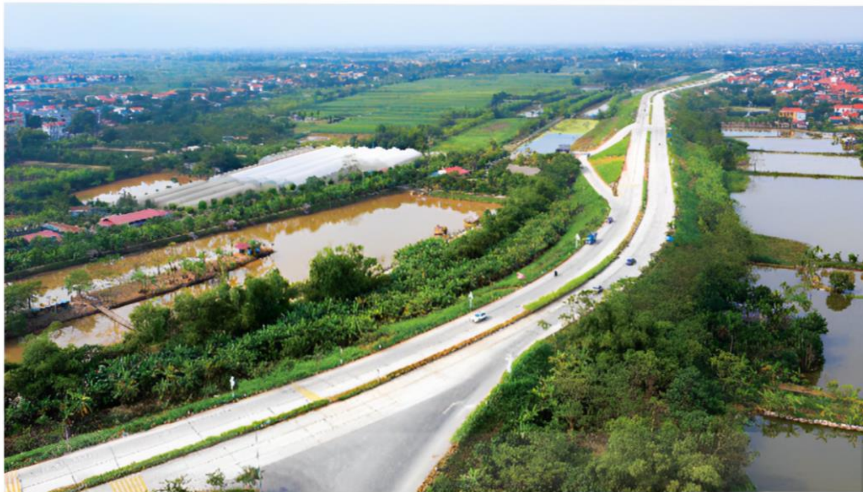
▲ Hình 5. Một đoạn đê sông Hồng
