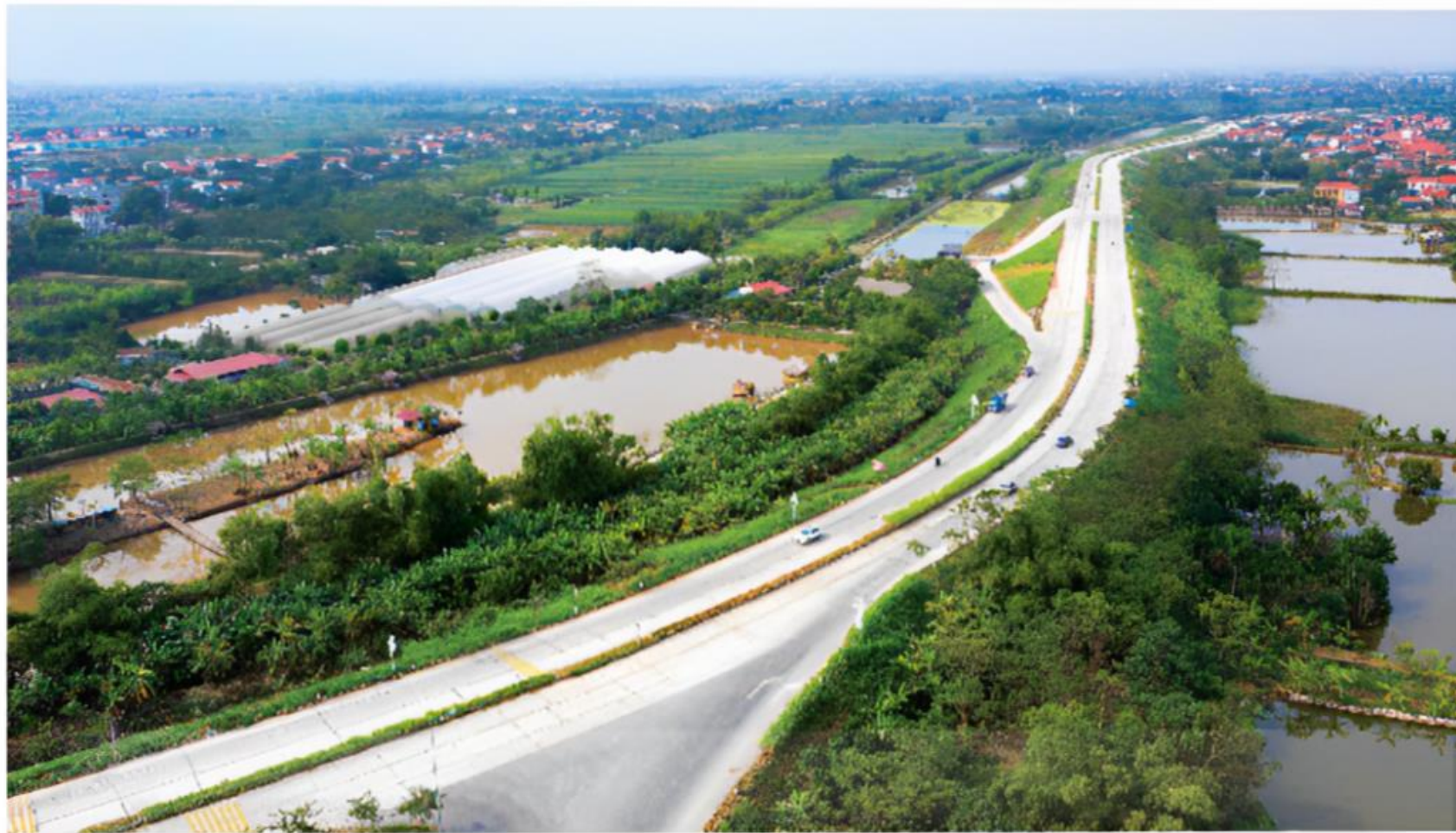
▲ Hình 5. Một đoạn đê sông Hồng
