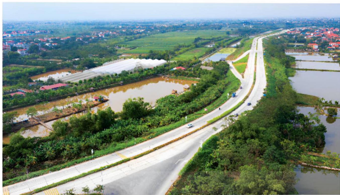
▲ Hình 5. Một đoạn đê sông Hồng
